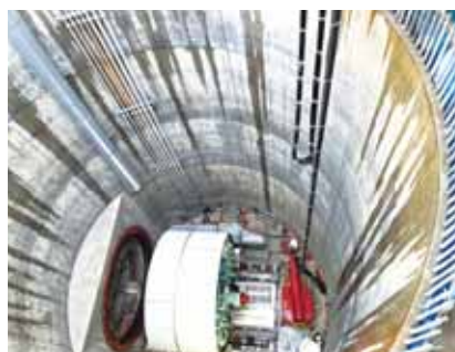
立坑上部から底部を見た様子
