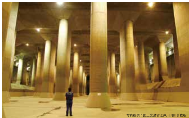
▲首都圏外郭放水路。全長6.3km、地下約50mに内径約10mの地下トンネルを通して江戸川に流す、世界最大級の地下放水路。
